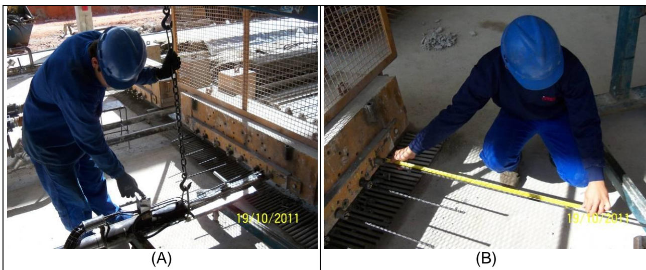
Figura 6: Operação de protensão (A) aplicação da protensão na cordoalha (B) Medição do alongamento na cordoalha protendida
